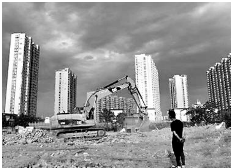
资料图:工人操作挖掘机在山西太原一商品房建设工地施工作业
